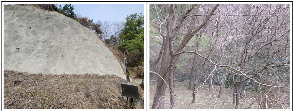
【사진 1.3.13】 사면 전경
